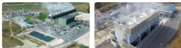
地熱発電設備 バイナリー発電設備
